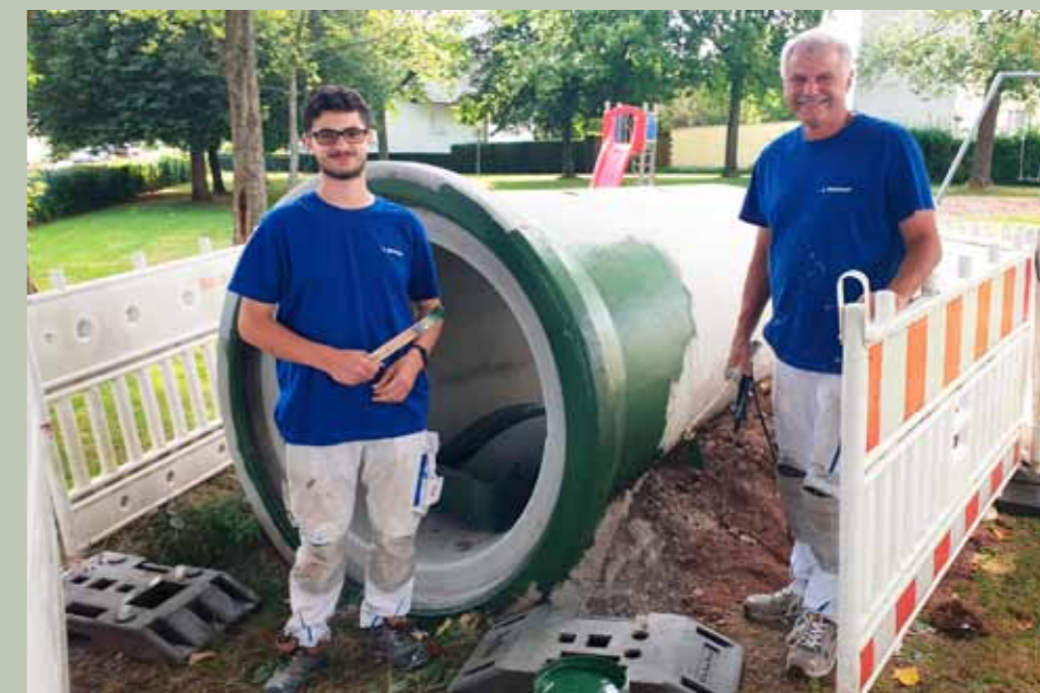
Mitarbeiter der Firma Degel
